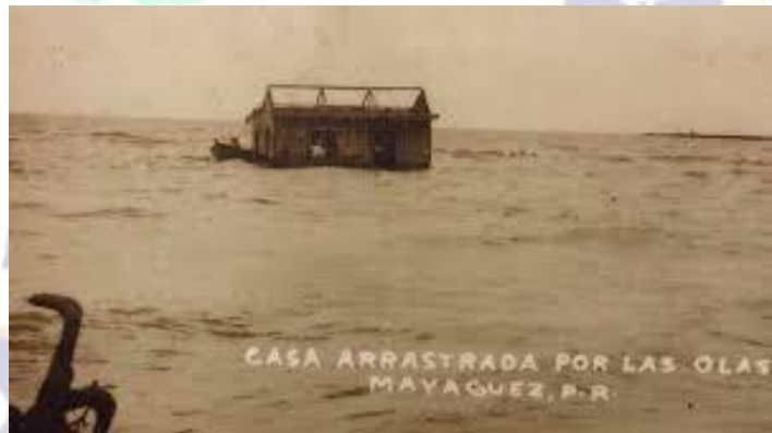
Evento de Terremoto y Tsunamis, Puerto Rico 11 de octubre de 1918
